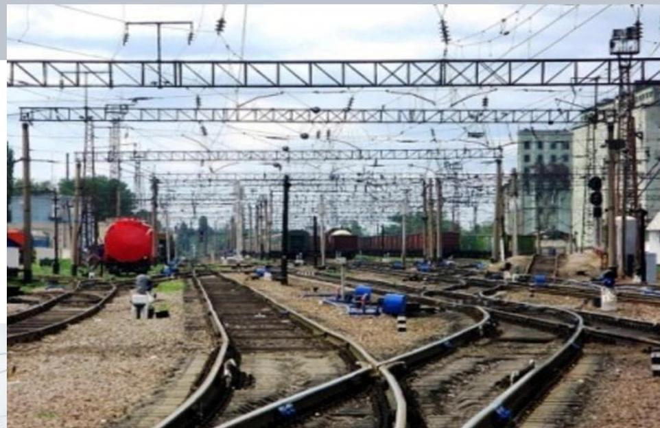
2) **участковые** – предназначены для смены локомотивов и их экипировки, технического обслуживания и коммерческого осмотра составов, расформирования и формирования составов сборных и участковых поездов, технического обслуживания и ремонта вагонов, а также для выполнения пассажирских, и грузовых операций;
